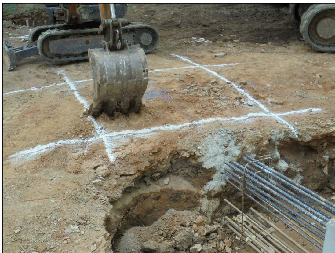
68. Inici excavació d'encepat P16.
