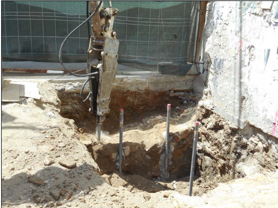
23. Desmuntatge del mur de façana de l'edifici enderrocat UE029, encepat P1.
