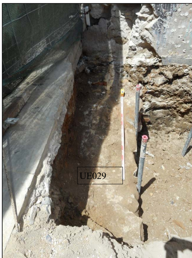
22. Mur de façana de l'edifici enderrocat UE029, encepat P1.
