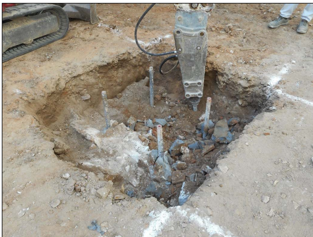
28. Encepat P6, Mur UE030-031 desmuntatge.
