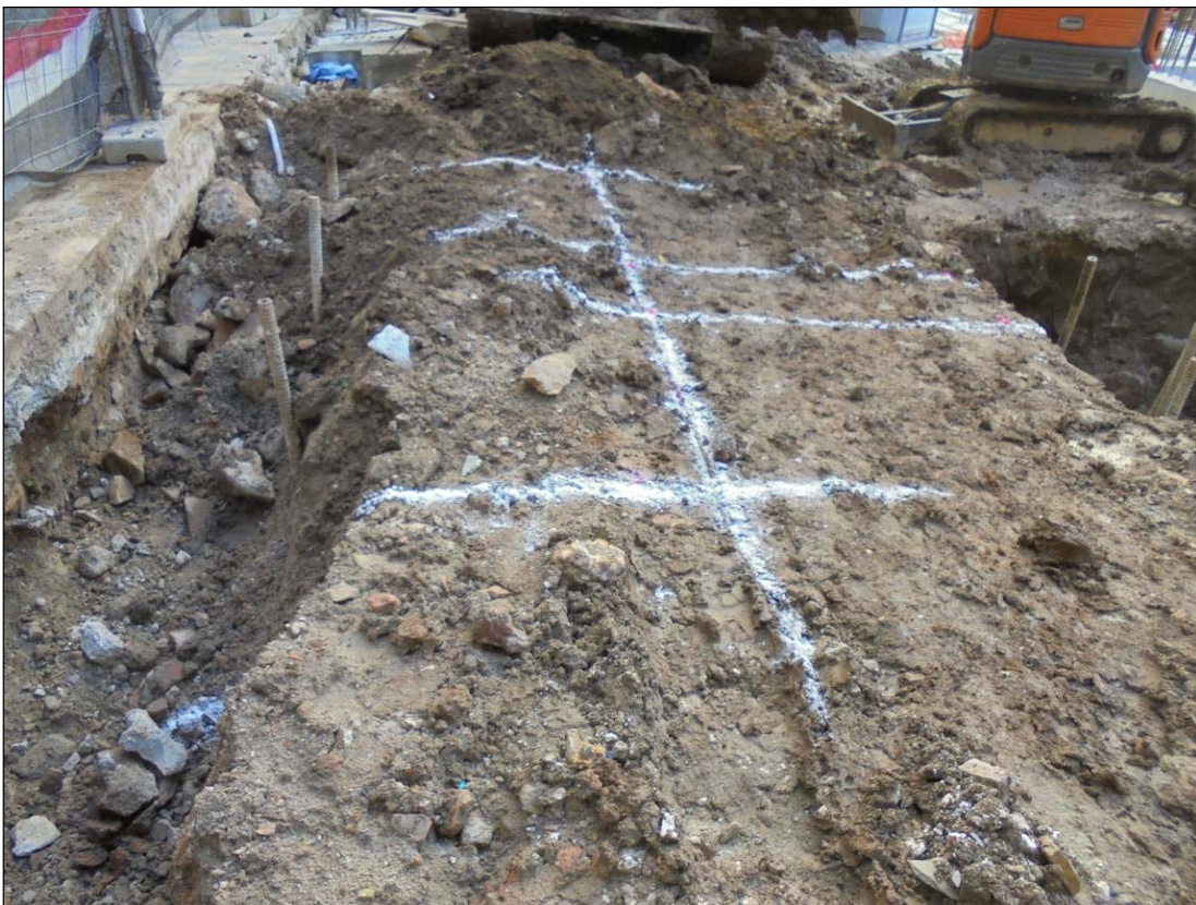
60. Inici excavació d'encepat P3.
