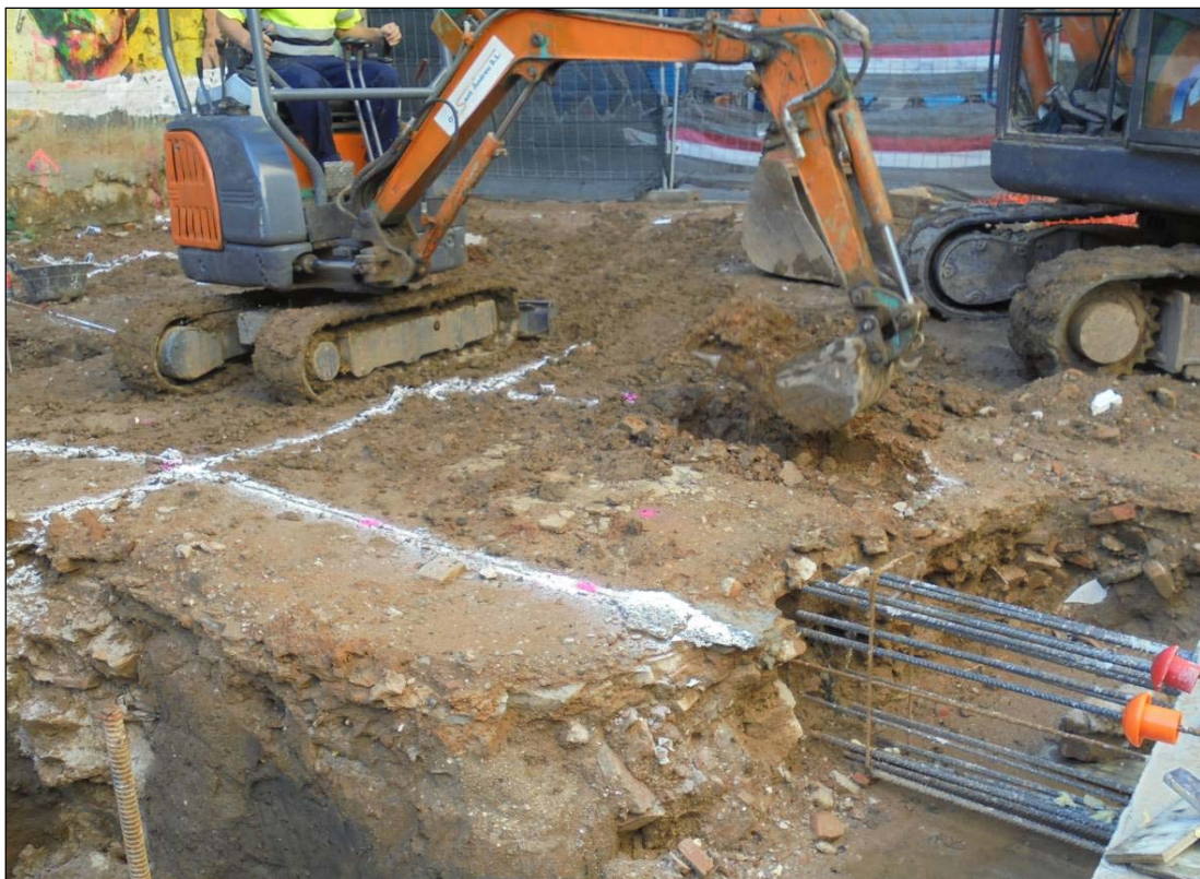
66. Inici excavació d'encepat P11.
