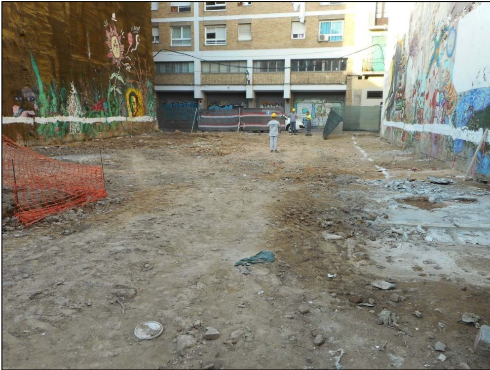
1. Vista general del solar on es realitza la intervenció.
