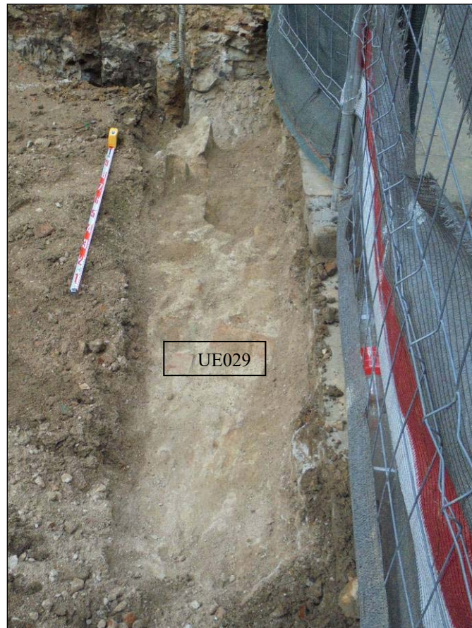
65. Estructura en la riosta entre P3 i P4.
