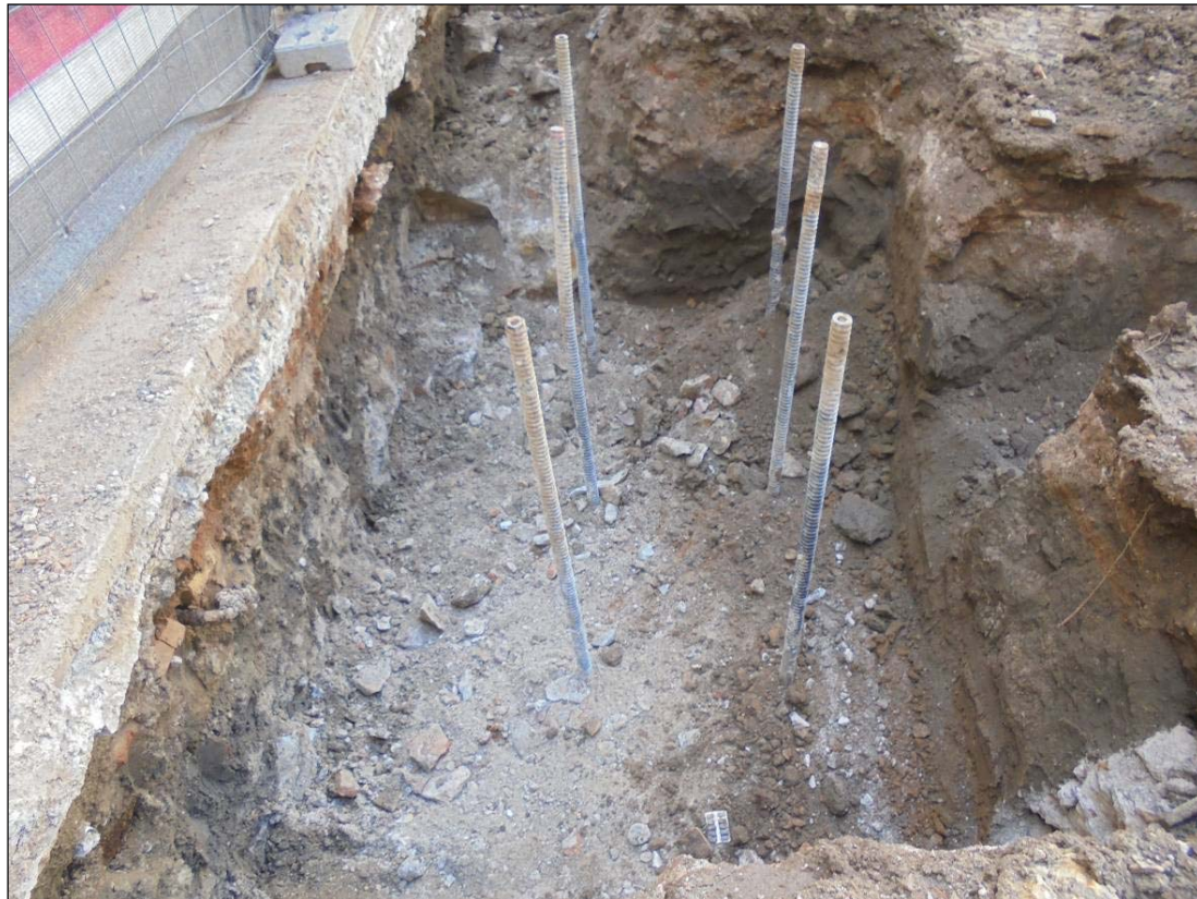
62. P3 amb les estructures desmuntades.
