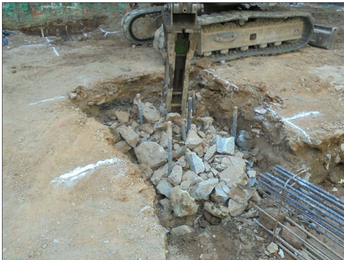
70. Desmuntatge de les estructures de P16.
