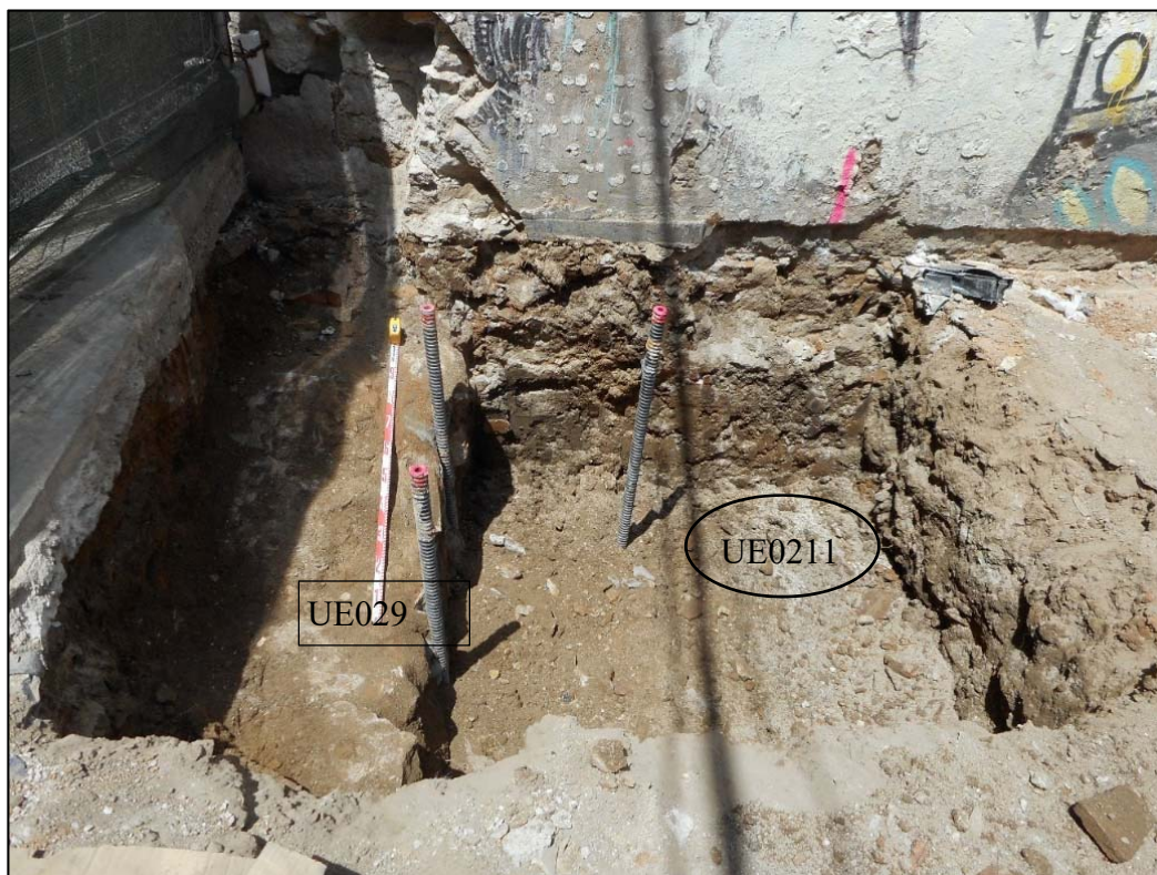
21. Mur de façana de l'edifici enderrocat UE029, encepat P1.
