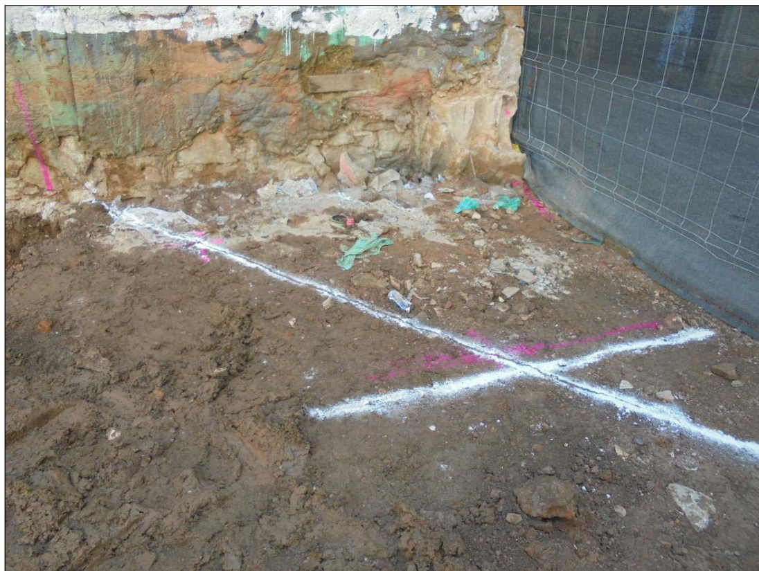
63. Inici excavació d'encepat P4.
