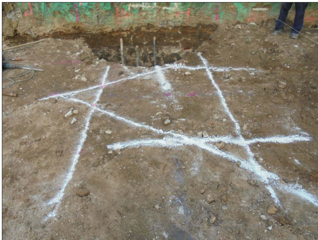
71. Inici excavació d'encepat P17.
