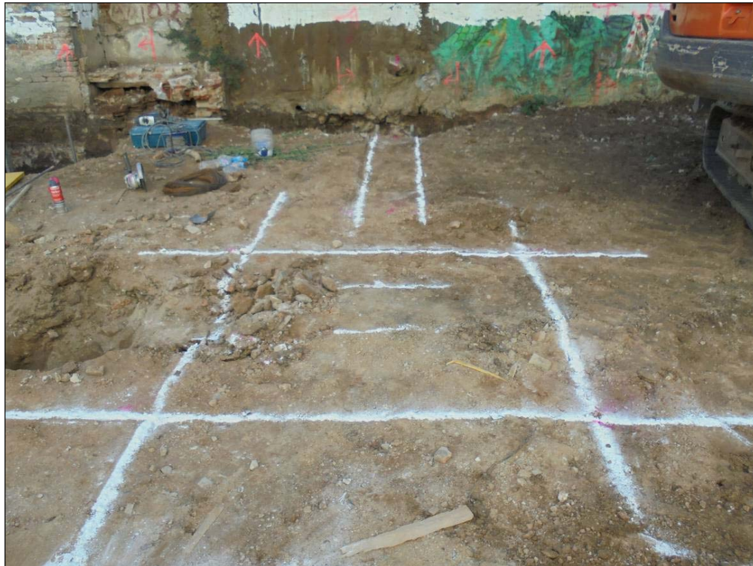
74. Inici excavació P21.
